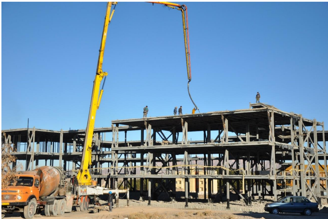
پروژه خوابگاه دانشجویی بنیاد ۱۵ خرداد در حال ساخت (۱۳۹۷)
